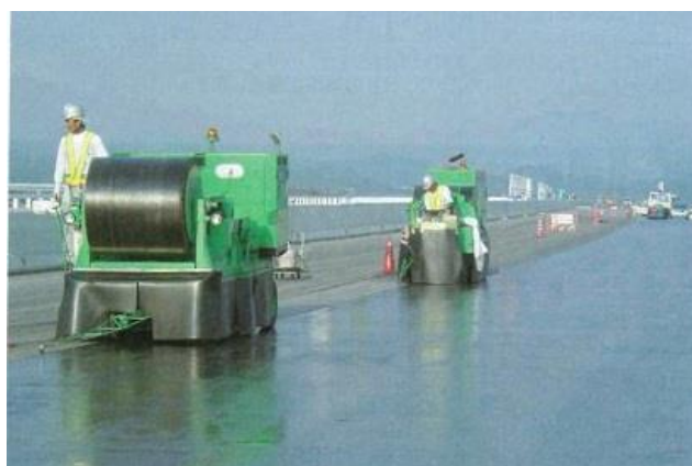
独自工法による防水工事の様子
