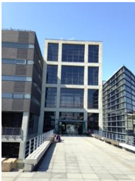
新台北市立鶯歌陶芸博物館入口。 立派な建物で裏は広大な公園。
