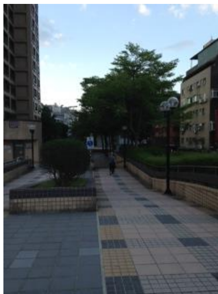
日本と違い、地下鉄（MRT）の上は緑地帯及び遊歩道となっている。
