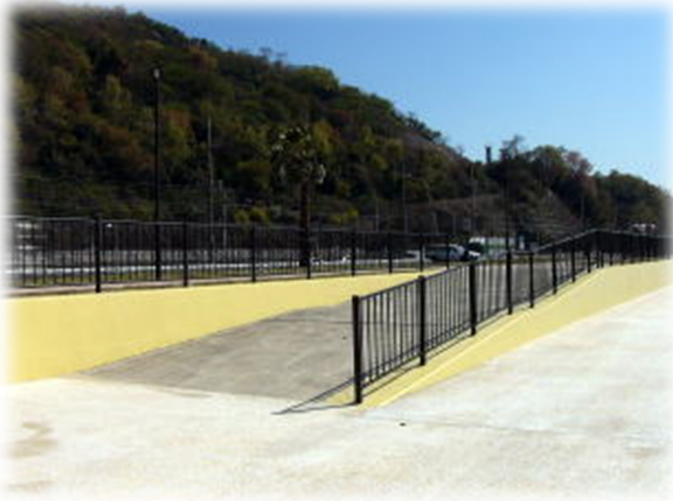
車いすスロープ
