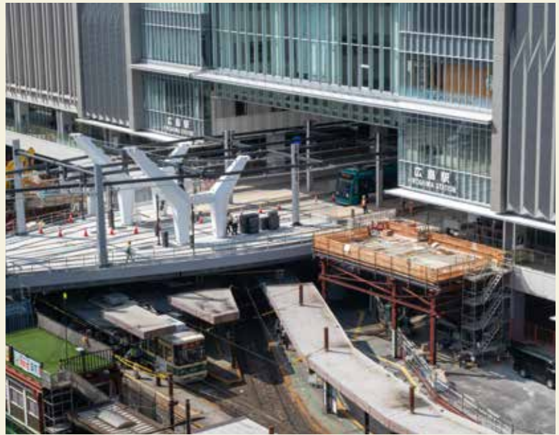
整備中の「駅前大橋ルート」から新広島駅ビル2階部分に乗り入れた広電の試運転車両。地上には営業運転中の車両が見える（2025年6月27日、広島電鉄提供）
