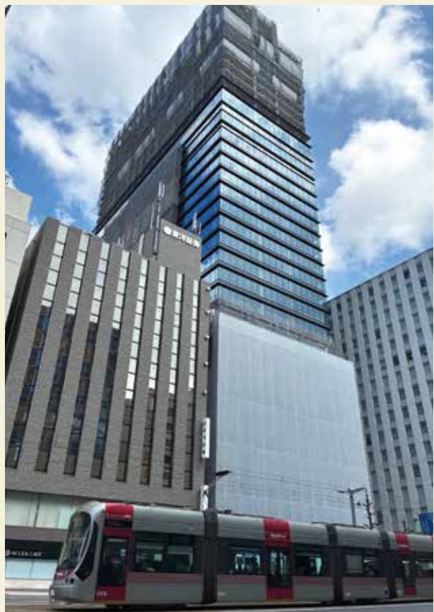
紙屋町・八丁堀地区再開発のシンボルとして建設中の高層ビル「カミハチクロス」と、JR西日本の新型車両デザインをラッピングした広電の路面電車（2026年1月21日、広島電鉄提供）
