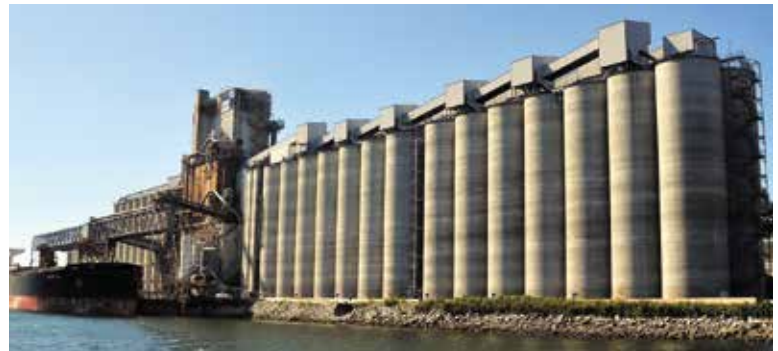
巨大なサイロから船に穀物を積み込むバンクーバー港の施設
